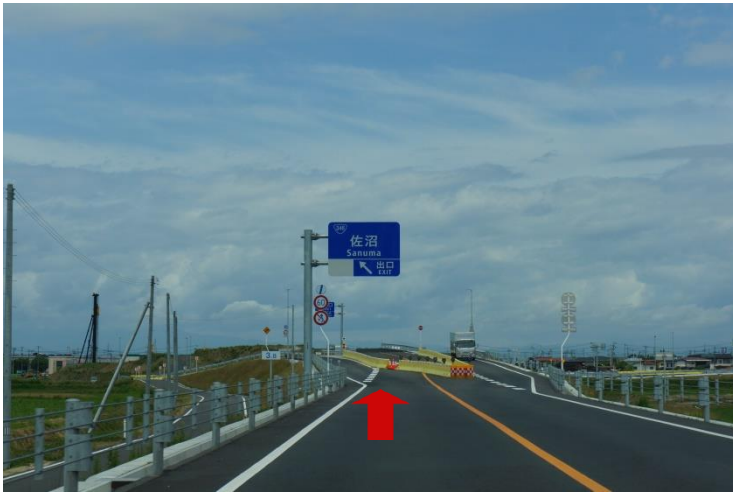
みやぎ県北道路 佐沼インターチェンジ（終点） 出口
